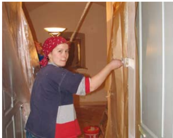
Die Gänge und Räume in Wambach haben Dank des tatkräftigen Einsatzes der Werkler wieder einen frischen Anstrich.
