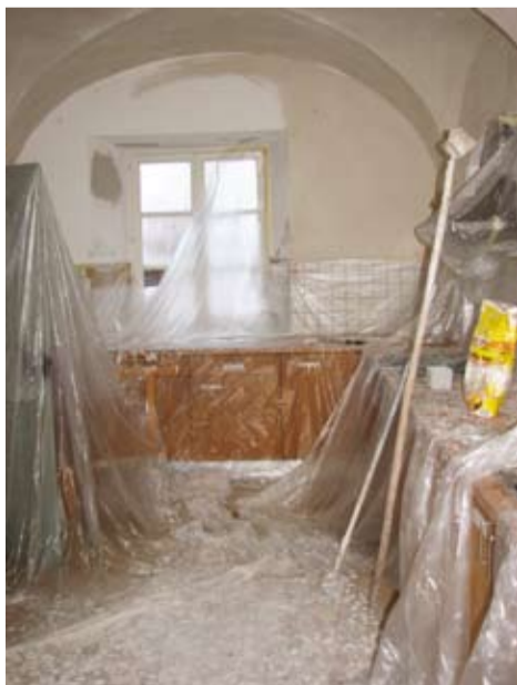
Auch die Küche erstrahlt jetzt wieder in reinem Weiß
