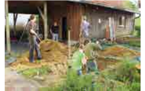
Öl? Gold? Nein - die abgesperrte Heizung!
